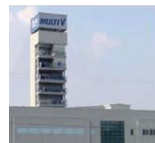
Testy długości instalacji
